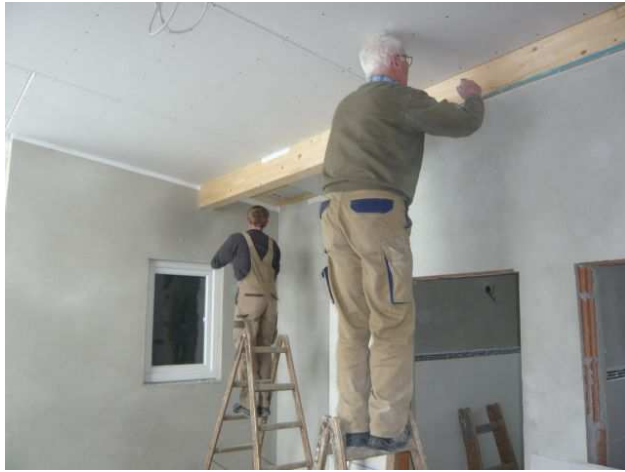
Anbringen der Unterkonstruktion an der Rigipsdecke von der Firma Lankes (Wolfgang Lankes sen.)
