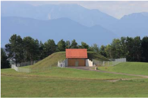
Der Hohenfurcher Hochbehälter
